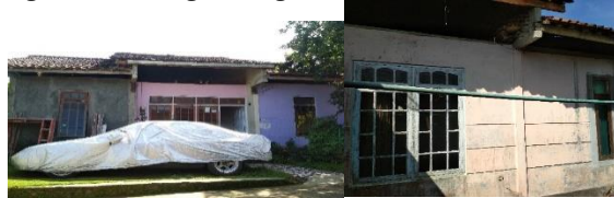
Gambar 1. Tampak Depan dan Belakang Bangunan
